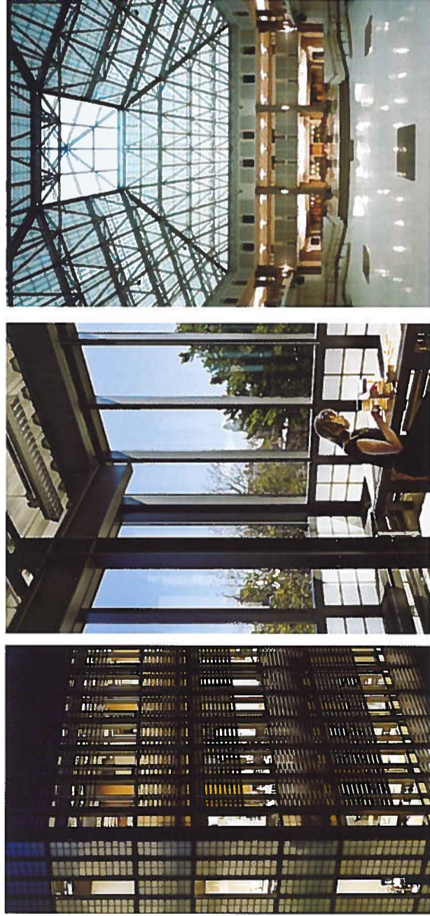
Figur 1. Translucent aerogel i bruk i Sculpture Building and Gallery of Yale University, New Haven, Connecticut, USA (Bilde til venstre og i midten) og KALWALL High-Performance Translucent Building Systems (Bilde til høyre).
