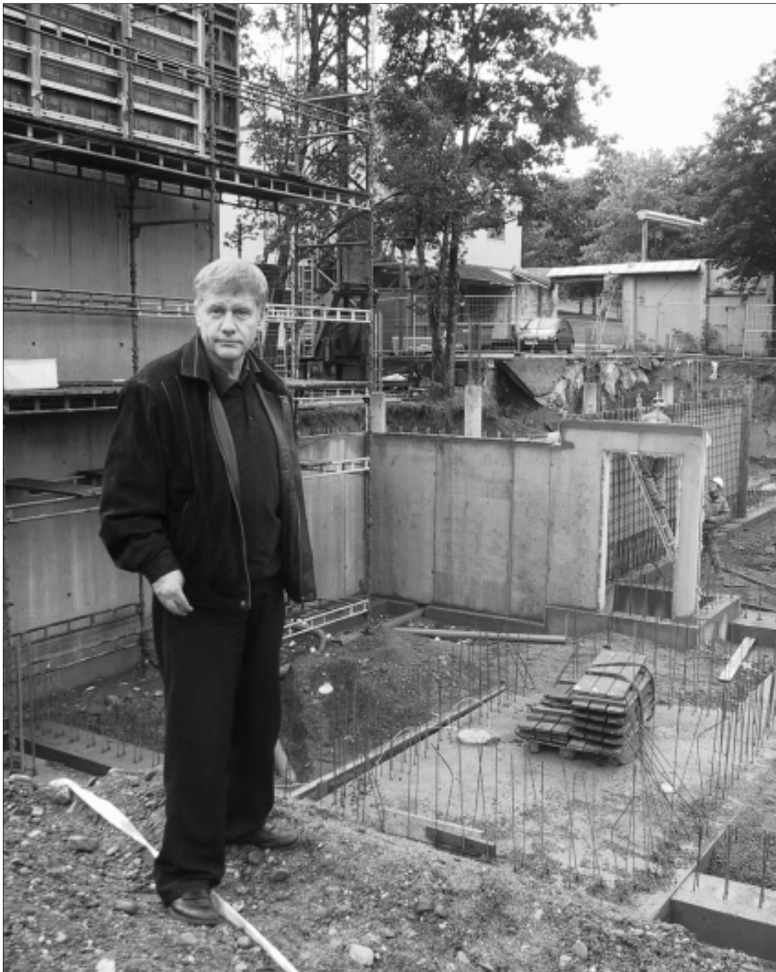
Det skal ikke stå på Samskipnaden! Direktør Odd-Roar Sjøhelle i SiT Bygg AS håper og tror at flere ungdommer med funksjonshemning vil søke høyere utdanning, når forholdene legges bedre til rette for dem.
