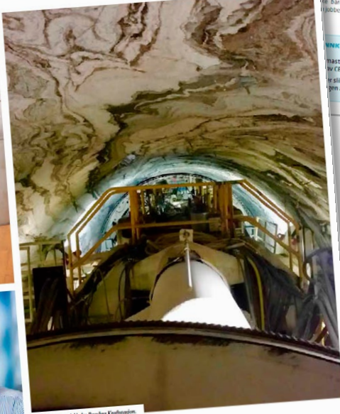
Rehabilitering på Nedre Rensåga Kraftstation
