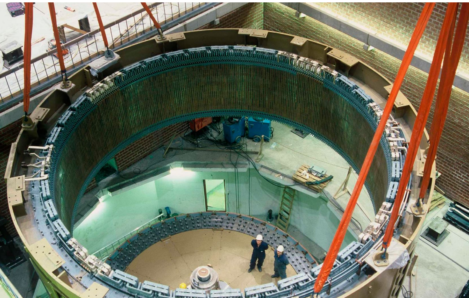
Montering i Kykkelsrud kraftverk. Foto: Alstom
