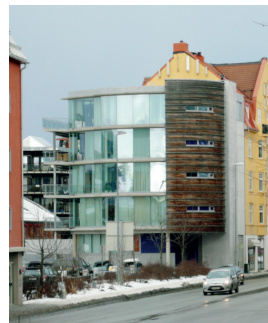
Figur 105 Bybolig «Søylen» i Trondheim, arkitekt P. Knudsen, 2004.
