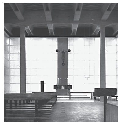
Figur 40 a, b Betongkonstruksjoner av arkitekten A. Mangiarotti inspirert av antikke konstruksjoner. Kirke nær Milano hvor taket av forspente betongelementer hviler på fire søyler. Fasaden er en dobbelt glassvegg med isopor mellom som gir en halvtransparent virkning slik at dagslyset filtreres inn i rommet.
