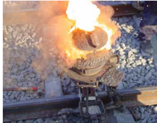
Figur 4.26 Termittreaksjon brukt for sveising av jernbaneskinner
