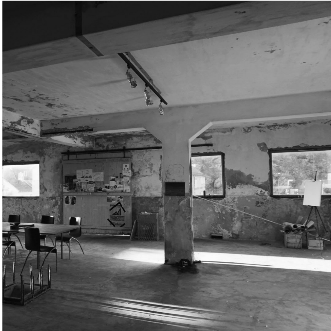
Bilde fra 2. etasje i fryseriet
