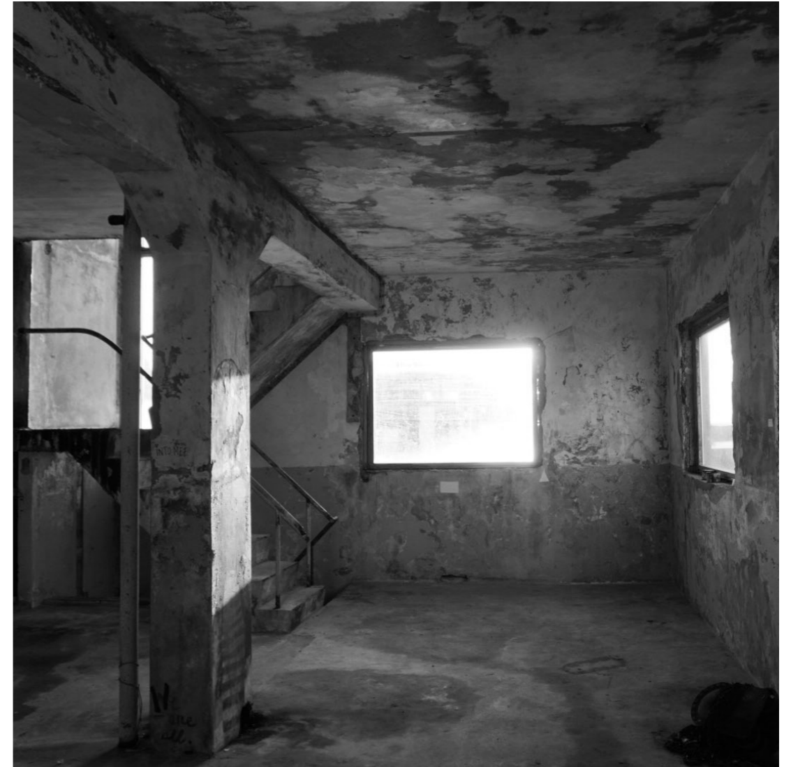
Bilde fra 2. etasje som viser eksisterende trapperom
