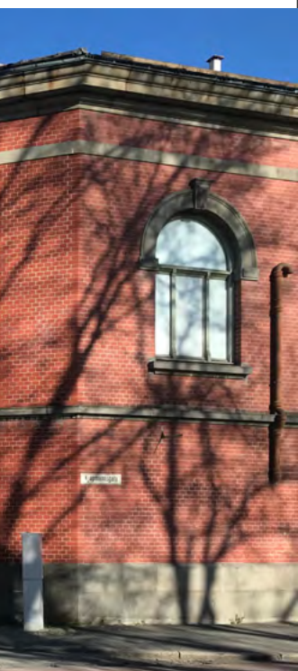
Overgang mellom øst- og sørfly. Til høyre et krysspostvindu med stabelhengler (V1)
