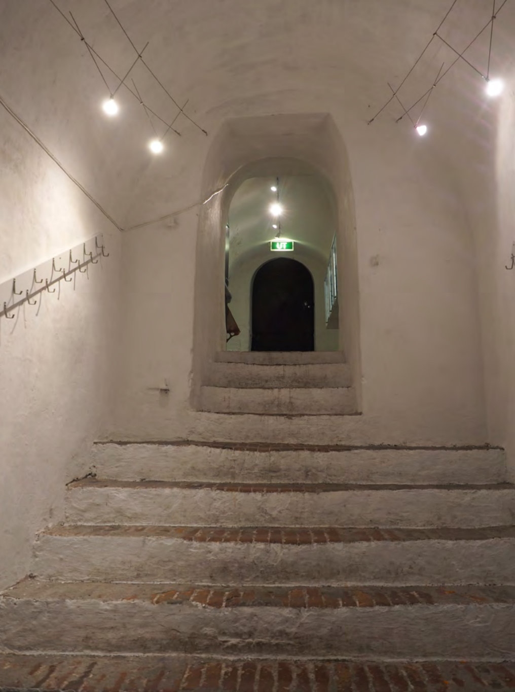
R0.12: Flott trapp med tegl i rulleskift leder opp gårdsrommet fra Angellkjellerne gjennom en hvelvet åpning. Foto: Kristin Marie Singstad
