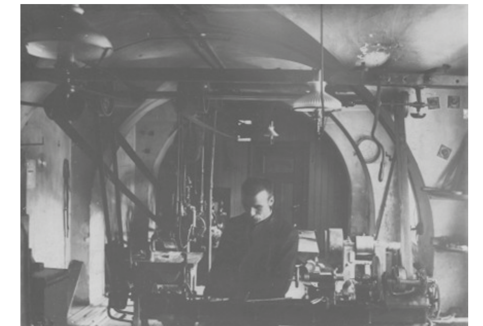
Figur 2.2.13: Maskinrom i krysshvelvkjeller under vestfløyen
