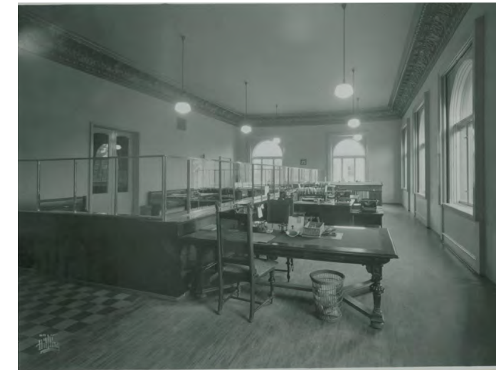
Figur 2.2.17: Ekspedisjonsrom i banksalen, året er ukjent. Detaljeringen rundt vinduer og dører, samt brystningspanel er fjernet. Himlingen har også mistet rosettene. Det eneste som er bevart er stukkaturen.
