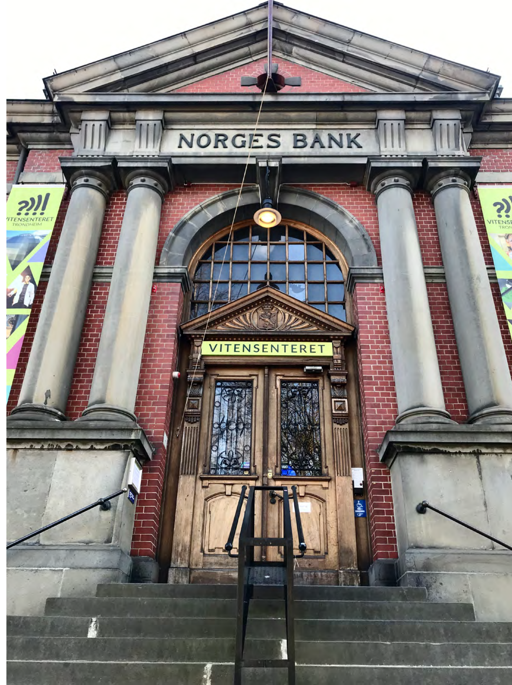
Inngangspartiet til Kongens gate 1
