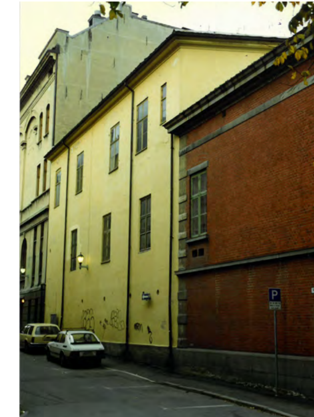
Venstre: Bilde av sørfasaden ut mot Vår Frue Strete tatt på befaring på midten av 90-tallet. Fasaden har en sterk gul farge og vinduene er i tilsynelatende dårlig stand. Foto: Frode Willmann, ca 1997
