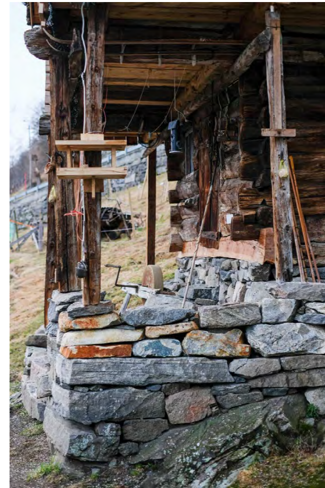
Steinmurfundamenter på Møllstunet i Geiranger. Egne foto.
