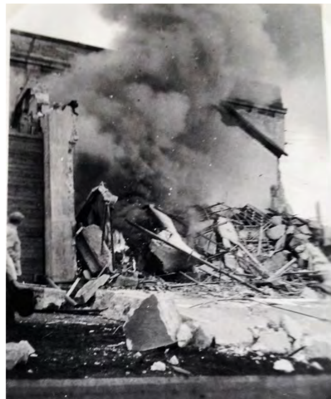
Bårdshaug omformerstasjon etter sabotasjeaksjonen hadde intruffet.
