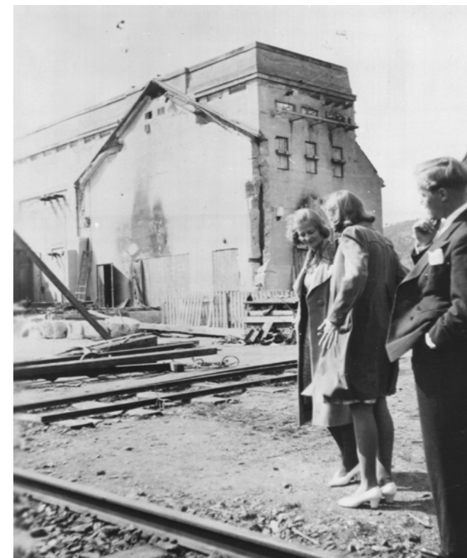
Maskinsalen ble sterkt skadet.
