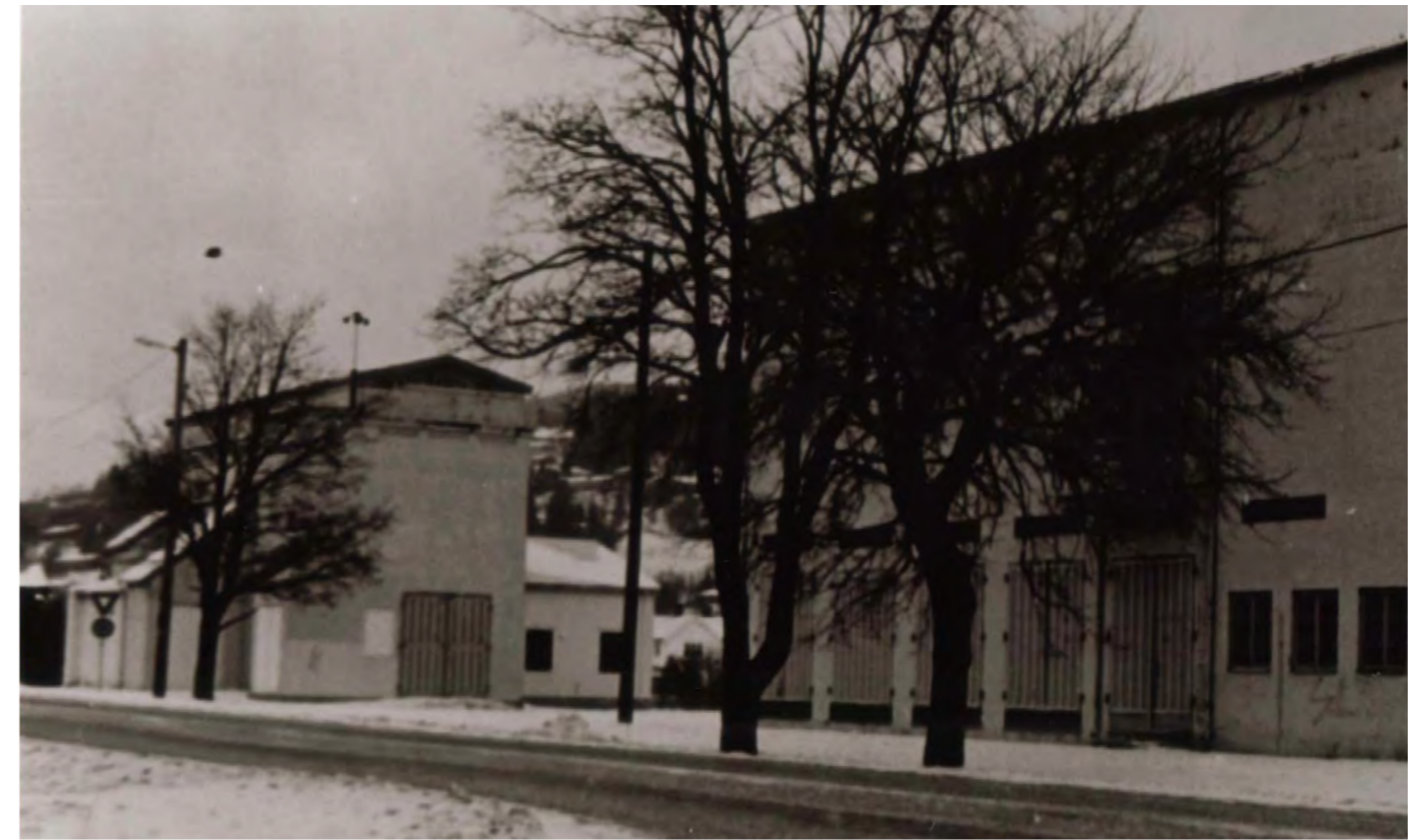
Bårdshaug omformerstasjon på 1990-tallet.
