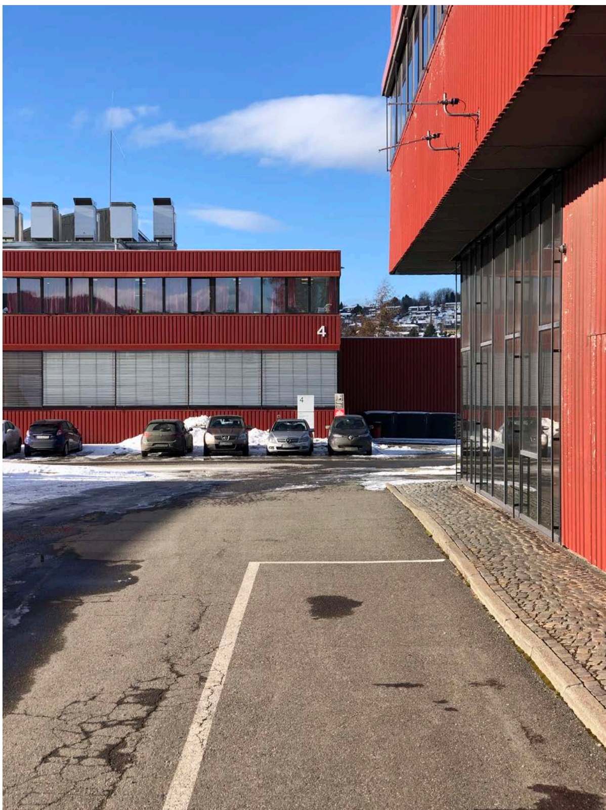
Administrasjonsbygningens base med verkstedbygningen i bakgrunn.
