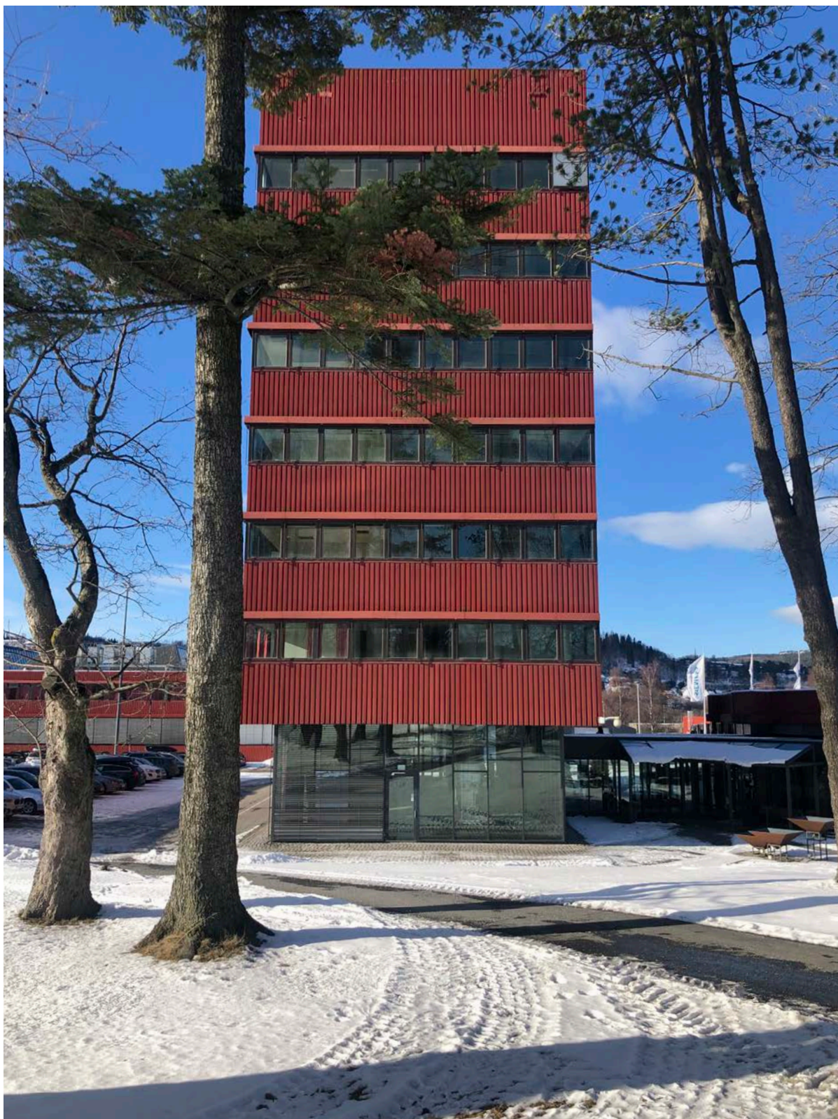
Administrasjonsbygningen, sett fra furulund i øst.
