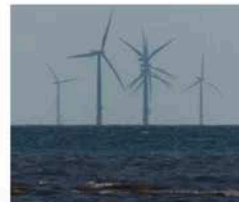
Fil:Lincs Offshore Wind Farm - geo...
