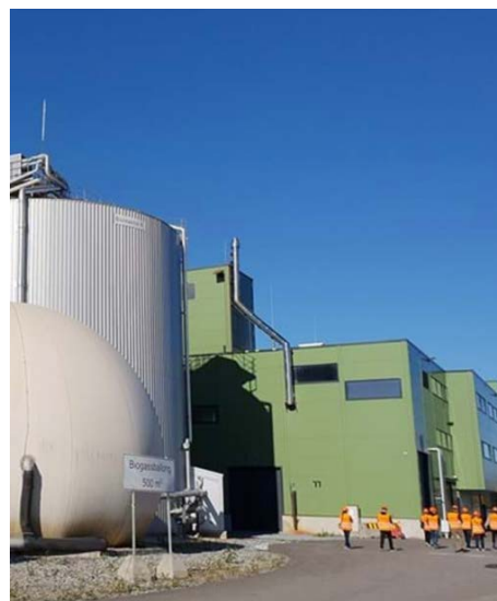
EGE-anlegget på Romerike. Foto: Cambi AS
