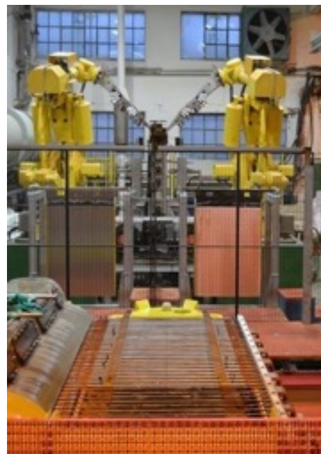
Bildet viser Glencore Nikkelverk sitt pilotanlegg for kobberproduksjon i Kristiansand. Foran er elektrolysetankene. Cellen til venstre er dekket med en ventilasjonshette som reduserer utslipp av avgasser. En robotisert strippemaskin for kobberkatoder kan sees i bakgrunnen. Foto: Glencore Nikkelverk, Oluf Bøckman..
