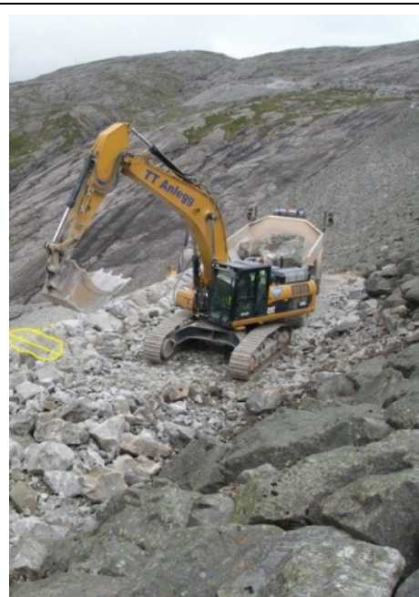
Plastring på fyllingsdammer.
