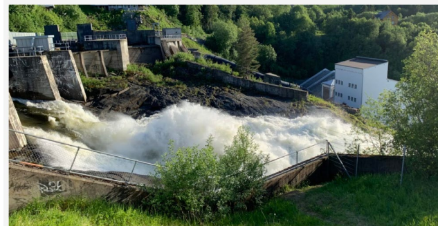
Vannkraftverket Nedre Leirfoss i Trondheim. Foto: SINTEF
