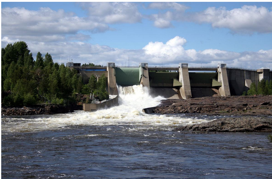
Stornorrfors dam, Umeå. Kilde: sv.wikipedia.org
