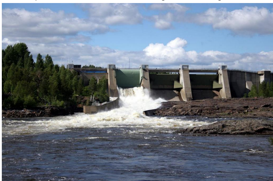
Stornorrfors dam, Umeå. Kilde: sv.wikipedia.org
