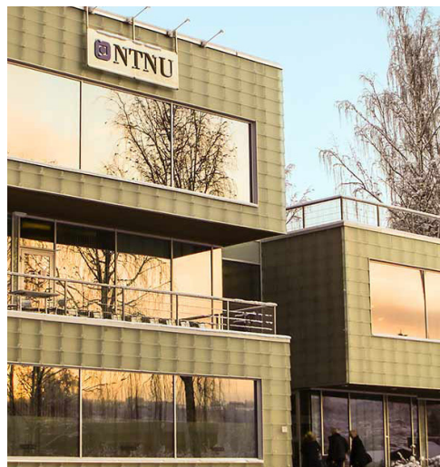
Hovedfasade påbygg (Foto: NTNU)
