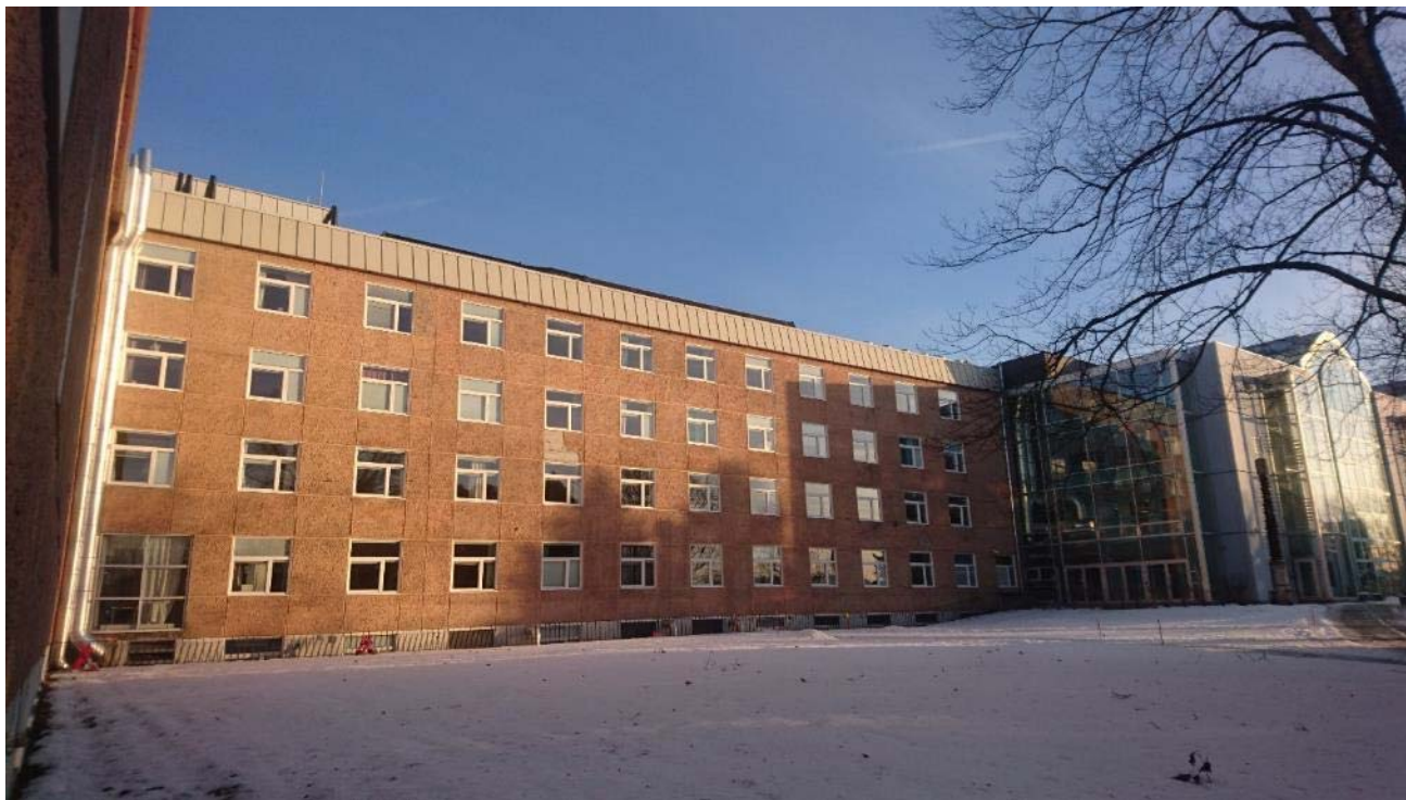
Sørvestsiden uten en eneste inngang/utgang mot flatt plenareal og Høyskoleparken.
