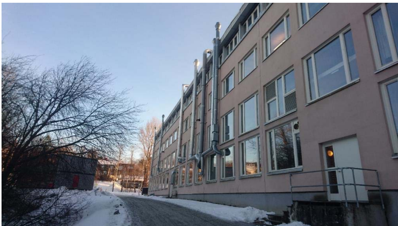
Bakside med og tekniske installasjoner mot Døsens dal, og nært et område vist som «erstatningsareal»
