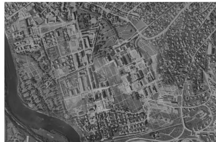
FOTO 1964: KJELHUSET OG SENTRALANLEGGET
