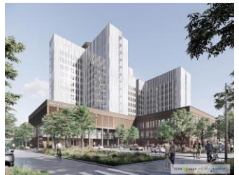
Oslo universitetssykehus HF Nye Aker
