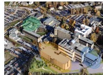
Sykehuset Telemark HF Utbygging somatikk Skien
