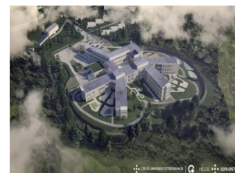
Oslo universitetssykehus HF Ny sikkerhetspsykiatri
