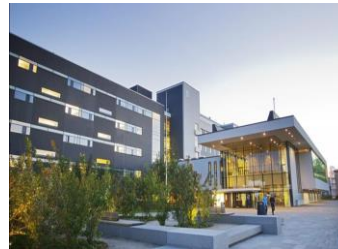
Akershus universitetssykehus HF Kreft- og somatikkbygg
