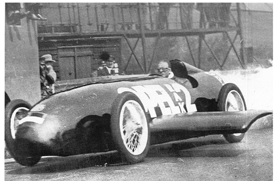
Fritz von Opels rakettbil som oppnådde en hastighet på 230 km/t i 1928
