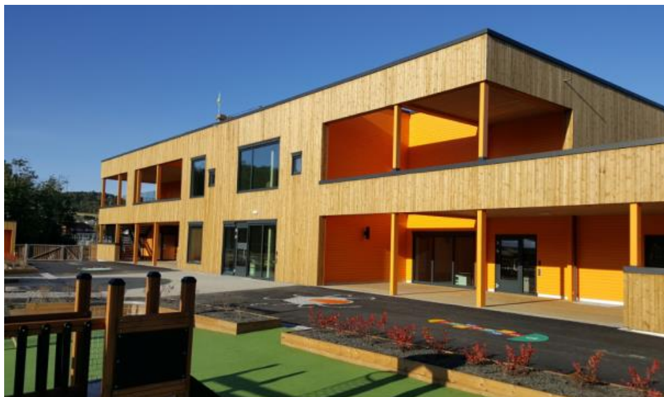
Figur 52: Bilde av Ranheimsfjæra barnehage (Kilde: https://trym.no/prosjekt/ranheimsfjaera-barnehage/ )
