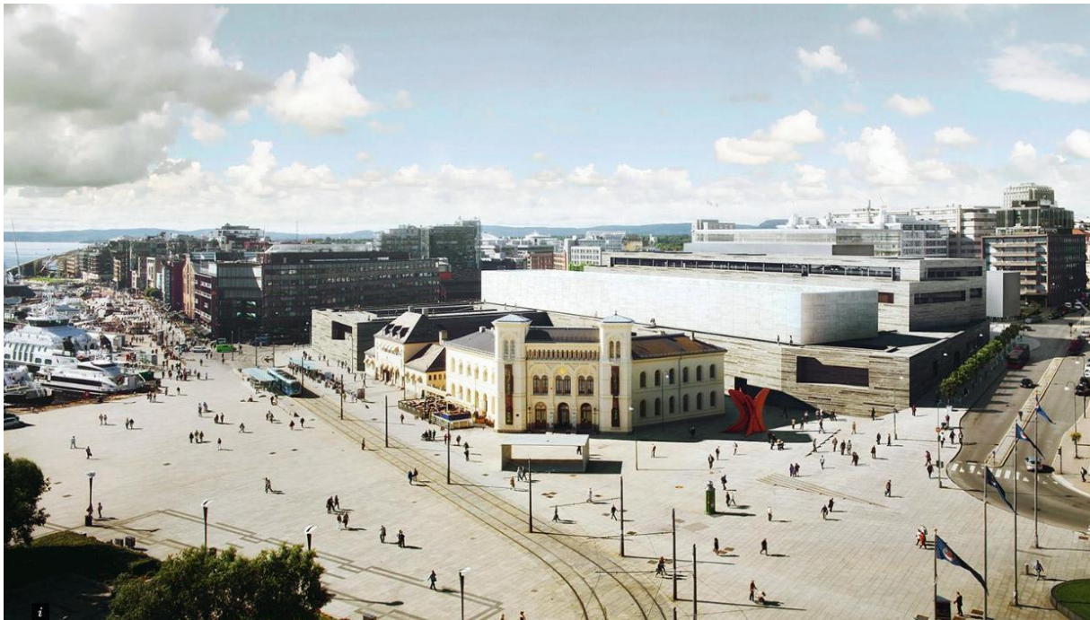
Bilde 1: Det nye nasjonalmuseet slik det etter planen skal bli seende ut. Etter at det ble besluttet at museet skulle lokaliseres på Vestbanen og ikke ligge på Tullinløkka som i dag har kostnadsestimatet økt betydelig. Samtidig økte standarden på det planlagte bygget (illustrasjon hentet fra www.nasjonalmuseet.no )
