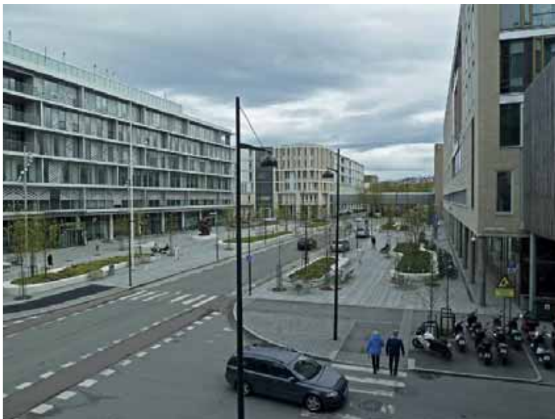
St. Olavs hospital i Trondheim ble mer enn ti ganger så dyrt som de første estimatene fra ivrige lokalpolitikere tilsa. Foto: Kommunal- og moderniseringsdepartementet.
