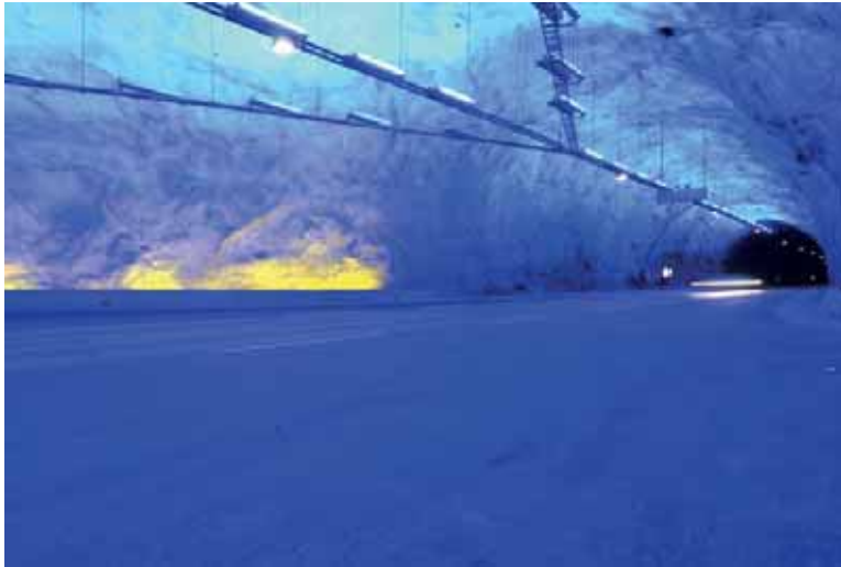
En fjellhall i Lærdalstunnelen, verdens lengste veitunnel, 24,5 km. Foto: Wikipedia
