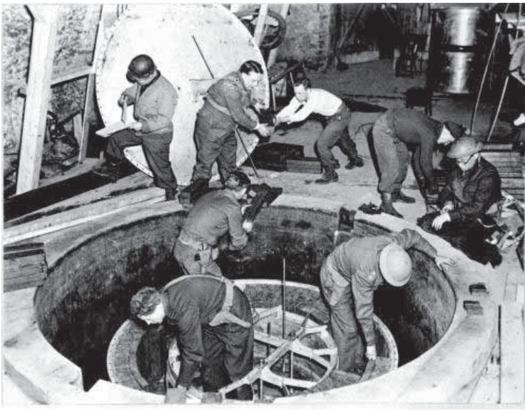
De alliertes demontering av den tyske forsøksreaktoren ved Haigerloch nær Stuttgart i april 1945. (kilde: Wikipedia)
