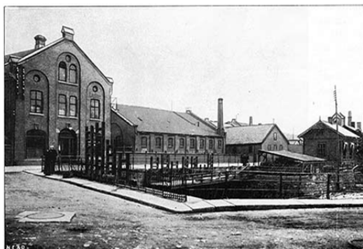
Laugstol Brug var det første kraftverket i Norge som solgte strøm til forbrukere. Kraftstasjonen lå innerst i Hjellen.
