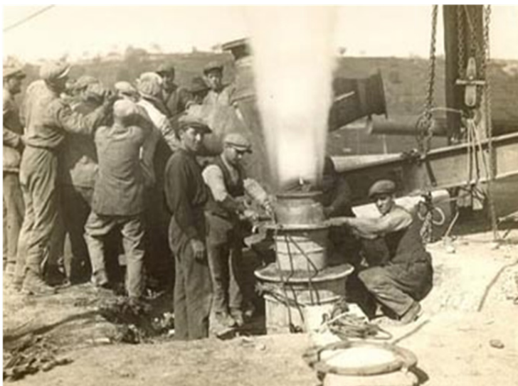
Verdens første geotermiske kraftstasjon ble bygget i 1911 i Larderello, i Valle del Diavolo, (Djevel dalen). Anlegget var verdens eneste industrielle leverandør av geotermisk elektrisitet frem til 1958, da et tilsvarende anlegg ble åpnet i Wairakei i New Zealand.
