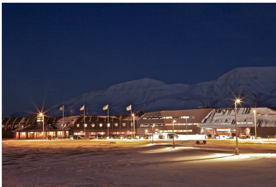
Svalbard forskningspark i Longyearbyen. Bygget sto ferdig i 2005 og ble evaluert i 2014. Evaluatoren konkluderte blant annet med at prosjektet var effektivt gjennomført og at det fremstår som relevant, primært med hensyn til det overordnede målet om norsk tilstedeværelse på Svalbard. Samtidig peker evalueringen på at man trolig kunne ha oppnådd mye av det samme på en rimeligere og kanskje mer hensiktsmessig måte.
