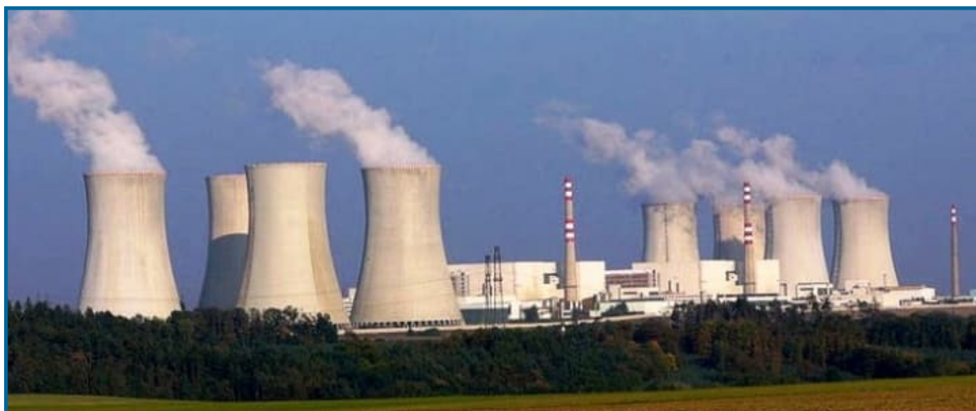
Figur 11. Kashiwasaki-Kariwa i Japan, verdens største atomkraftanlegg. Alle slike er i prinsippet dampmaskiner. Energien brukes til å koke vann, og dampen til å drive turbiner og generatorer som produserer strøm. Men det meste av energien går tapt som varme, derfor må kjøletårnene, som slipper ut vanddamp, være så svære at de dominerer bildet. De er et talende symbol på galskapen.
