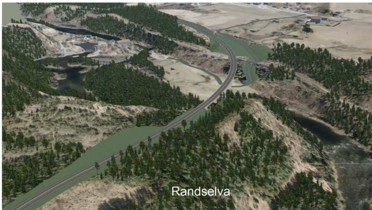
Figur 5 – Entreprise E1 - Randselva bru og ny veg til Kistefos
