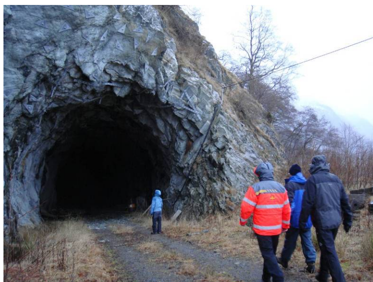
Figur 11-19 Vollabergtunnelen ved profil 1270. Fra befaring med SVV og KSG 21.1.2009
