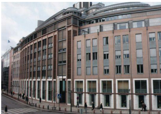
Figur 4-12 Regjeringsbygg 5 - Dagens største bygning i regjeringskvartalet. 48 000 kvadratmeter bruttoareal, bygget for 1 250 kontorplasser (Kilde: regjeringen.no)
