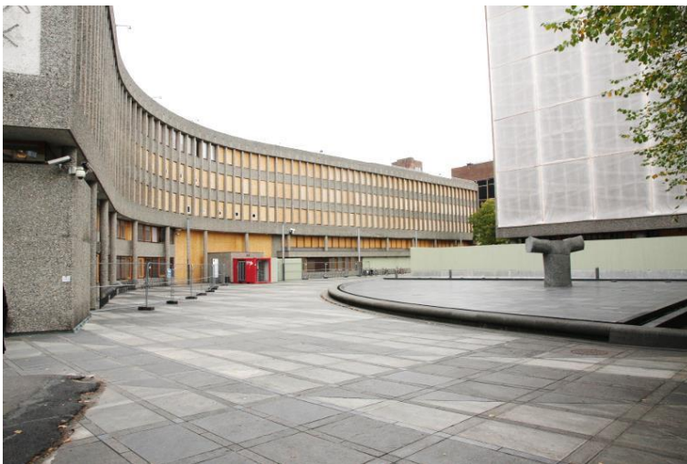
Figur 11-2 Ødelagte fasader på H- og Y-blokka (Foto: K. M. Rosseland)
