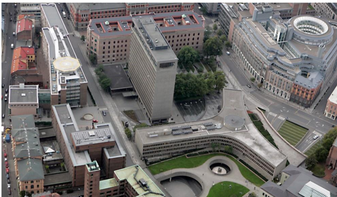
Figur 1-3 Regjeringkvartalet med den gamle regjeringsbygningen, Høyblokka, Y-blokka, S-blokka, R4, R5, M17 og M19. (Kilde: regjeringen.no)
