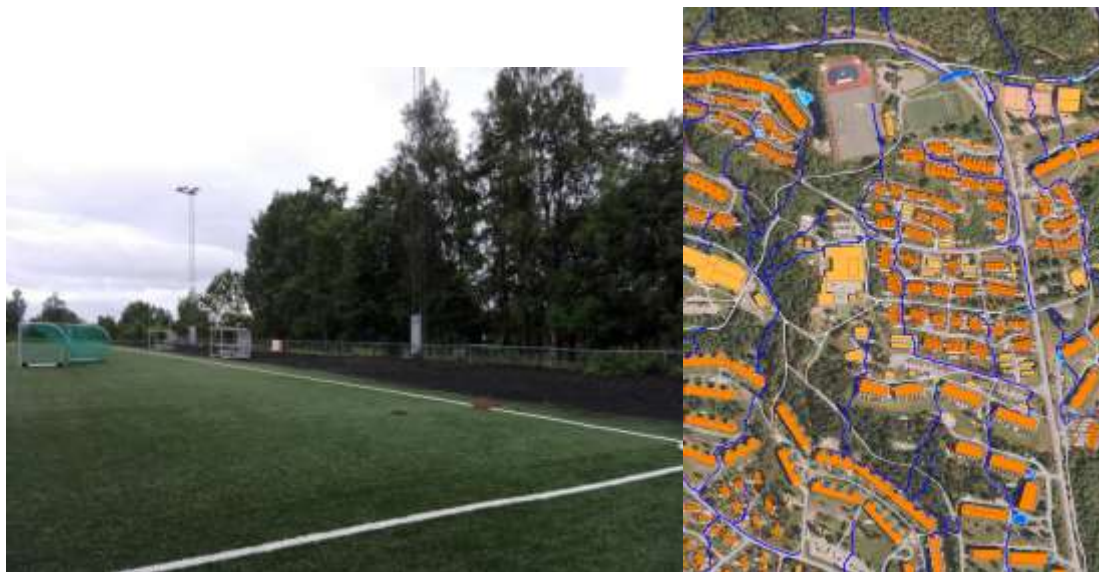
Venstre: Store granulatmengder på vestsiden av Gommerud kunstgressbane. Høyre: Kart med dreneringslinjer.
