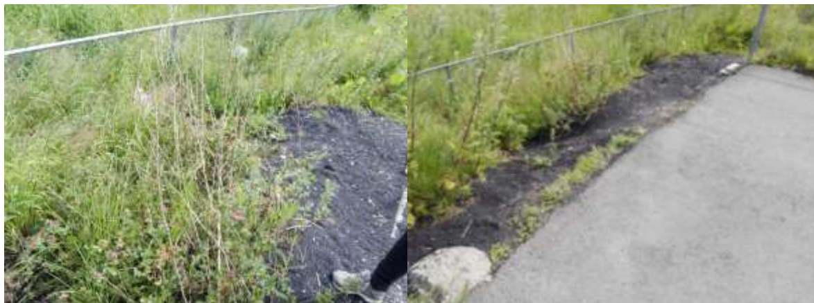
Bilder som viser store granulatmengder i grøfta bak målet på nordøst-siden av banen. Bak gjerdet begynner et landbruksområde.
