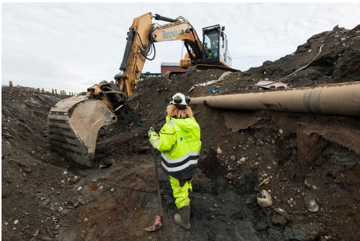
Figur 7: Arbeidsbilde; overvåkning av graving. Foto: Åge Hojem, NTNU Vitenskapsmuseet.
