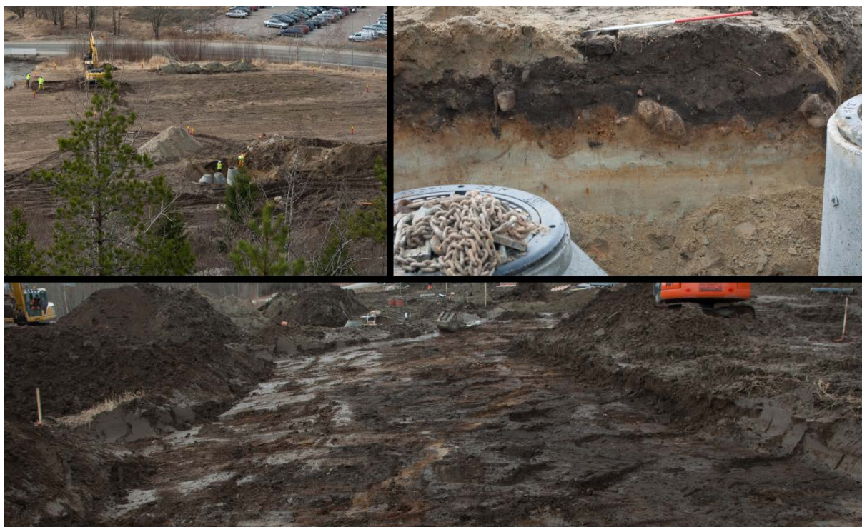
Figur 32. Eldre dyrkingslag påvist i anleggsgrøper nord for Felt 1. Bildene ovenfor t.v. (Da56531_005) og t.h. (Da56531_008) er tatt mot sør. Bildet nedenfor er tatt mot VSV (Da56531_21). Foto: Ovenfor t.v. Tanja Larssen 2013, de andre Dag-Øyvind Engtrø, NTNU Vitenskapsmuseet.
