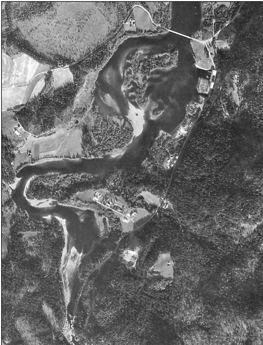
Figur 2.2 Flyfoto av strekningen Løkaunet – Svean bru tatt i 1961.
