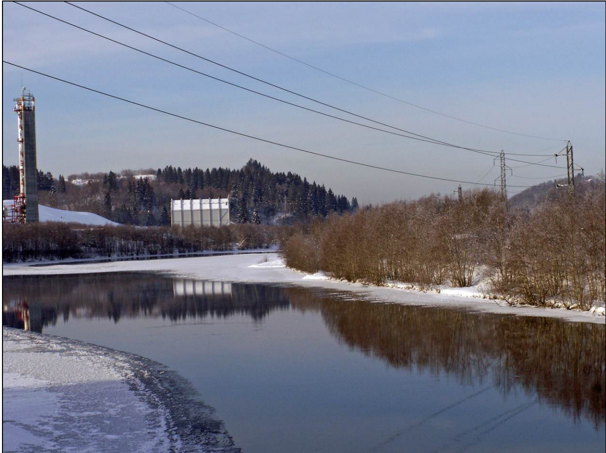
Bilde 3.4. Høyspentledningene som krysser Nidelva nedenfor Tillerbrua er en typisk representant for en kollisjonsutsatt trasé. Slike linjeføringer bør markeres med avledere. Foto: Per Gustav Thingstad
