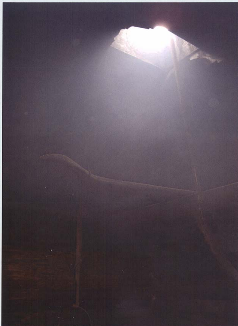
Røykstove med open ljøre. Røyken gjekk ut i rommet og opp gjennom ljøren i. Slik vart raftet fort sotet.
