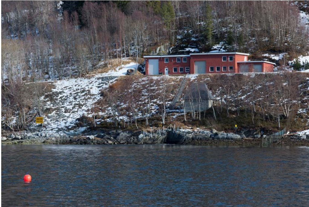
Bilde 9: Utløpet fra Sjøa Kraftverk til Hemnfjorden. Lyttestasjonen var festet 5 meter under blåsa. Foto: Åge Hojem
