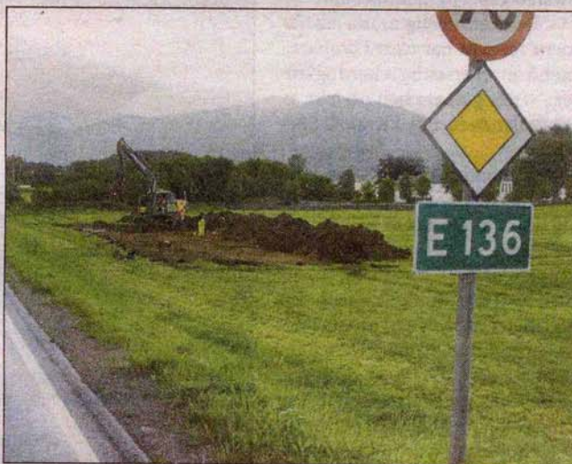
Her kjem vegen: Utgraving før bygging av ny tilførselsveg til Tresfjordbrua i Vikebuk.
