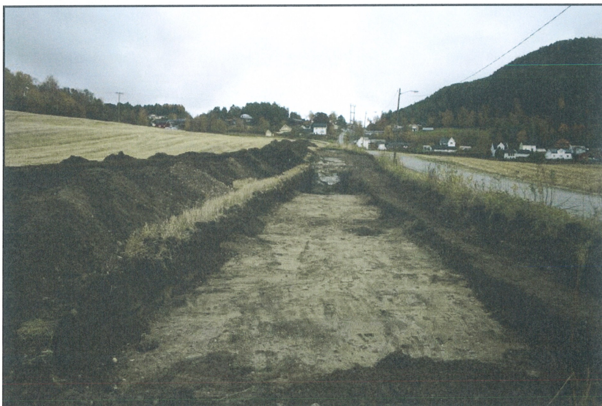
Figur 1: Bilde av lokaliteten plassert lang Liavegen. Tatt mot ØNØ.
