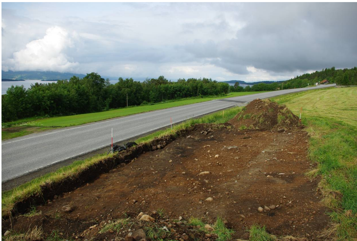
Figur 5: Felt 1 etter avdekking. Den moderne dreneringsgrøfta vises som en lysere stripe til høyre på bildet. Fundamentet til den gamle bygdeveien går inn i profilen mellom stikkstengene til venstre i bildet. Tatt mot SV. Foto: RS.
