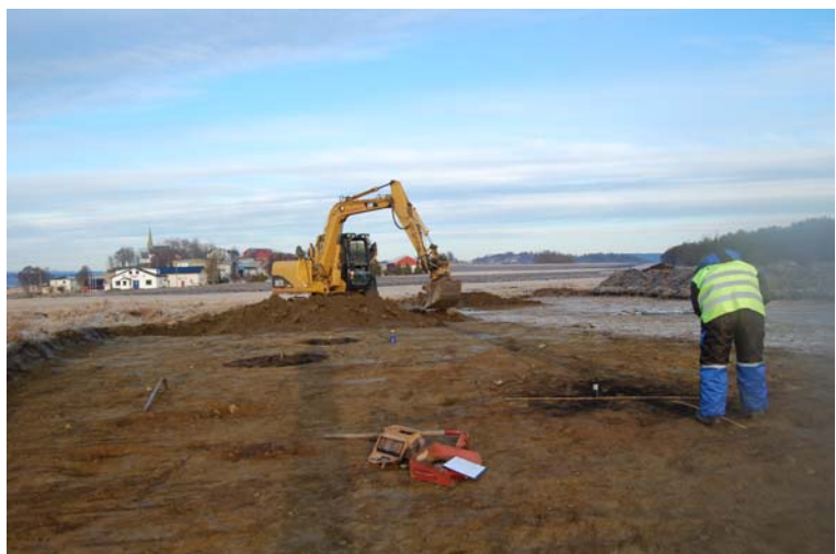
Figur 1. Arbeidsbilde med Alstadhaug kirke i bakgrunnen. Foto: Nina Lundberg
