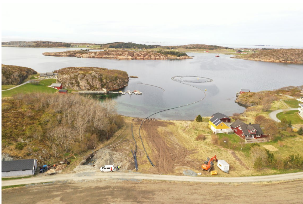
Figur 1. Foto som viser lokaliteten og tiltaksområdet før graving. Vannledningen er allerede på plass oppå lokaliteten og venter bare på endt utgraving. Den ble naturligvis flyttet før utgravingen fant sted. Sett mot N. Da64654_002. Foto: Kristoffer R. Rantala, NTNU Vitenskapsmuseet.
