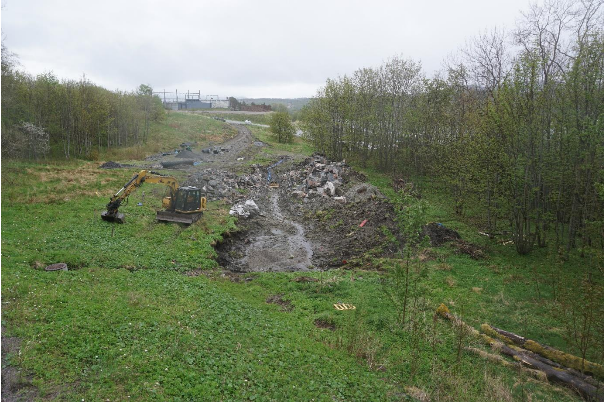
Figur 2. Lokaltet forut for avdekking. Påbegynt trasé for vannledning kan ses. Da64603_002. Foto: Astrid Kviseth, NTNU Vitenskapsmuseet
