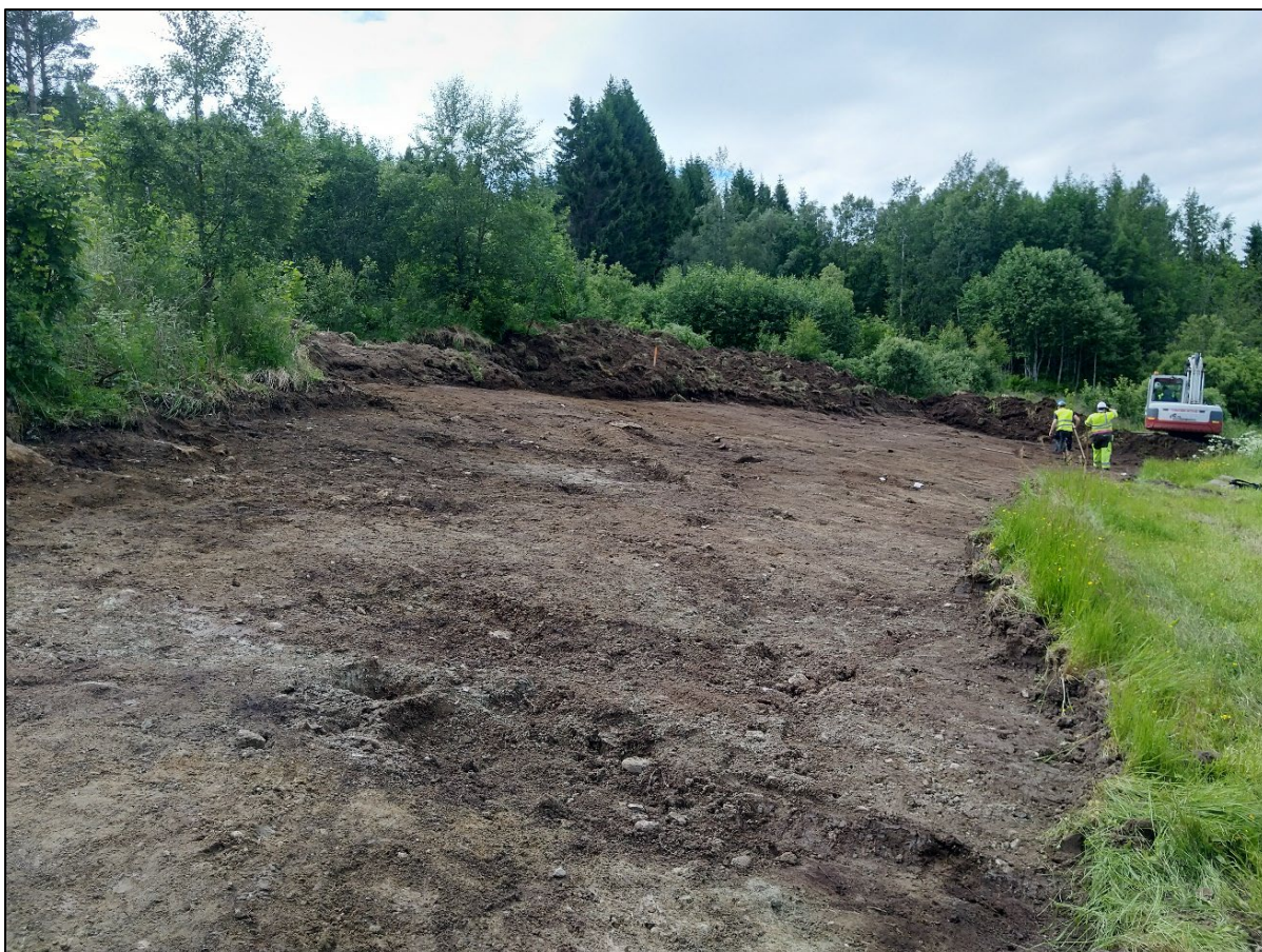
Figur 52. Otnes 2 under avdekking. Da63253_005. Tatt mot vest. Foto: Eystein Østmoe, NTNU Vitenskapsmuseet
