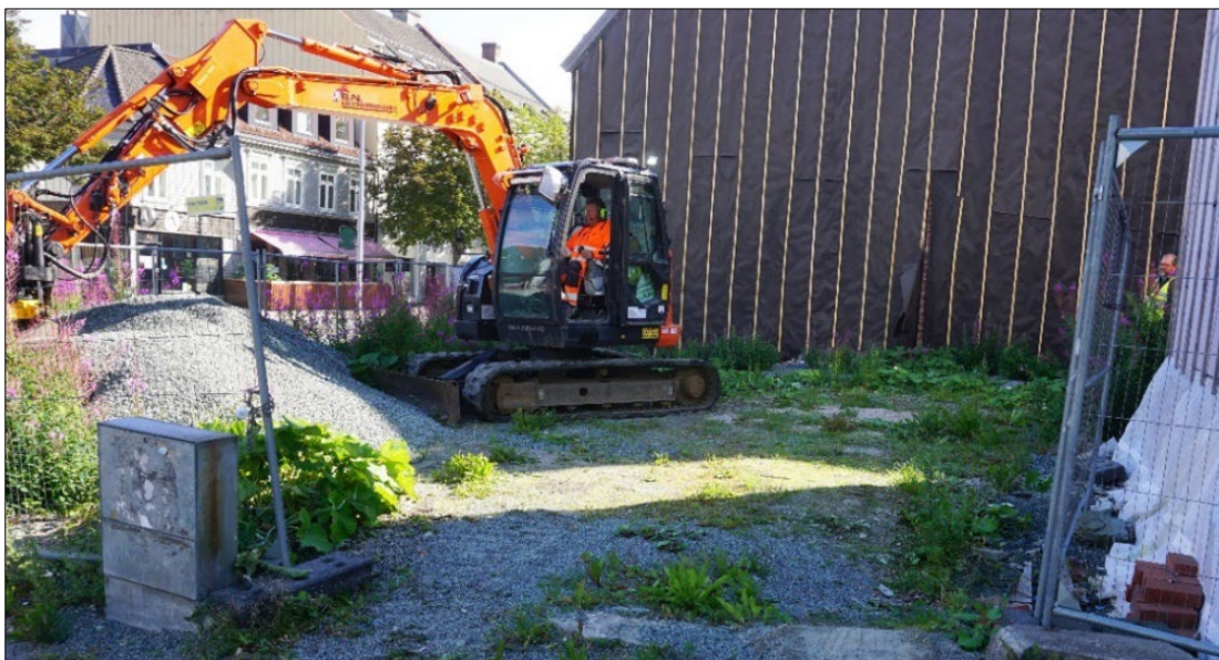
Figur 1. Området før utgraving. Da64097_001. Foto: Philip N. Wood, NTNU Vitenskapsmuseet
