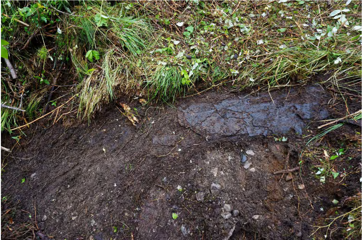
Figur 358. En veiduk var lagt i deler av veien og dukket opp under torven. Da63658_023. Foto: Eystein Østmoe. NTNU Vitenskapsmuseet
