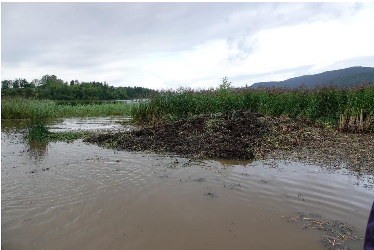
Figur 4.2. En av de to kunstige øyene lengst sørøst i Vassbukta fotografert 11.8 2022 mens den fortsatt var under konstruksjon. Den ligger bak beskyttende takrør. Foto: Magne Husby.
