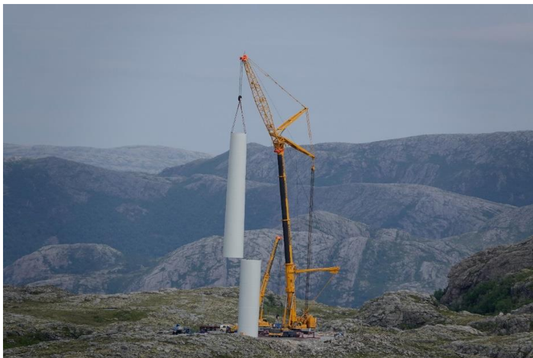
Bilde 2.1. Montering av tårnelement et sted på Sørmarkfjellet 26 juni 2021. Foto: Magne Husby.
