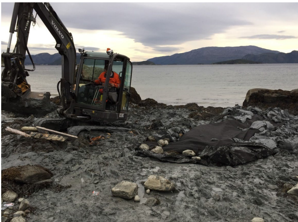
Figur 12: Gravemaskin ble benyttet for å legge masser oppå duken. Bildet viser tydelig hvor bløt leira kan bli, og vanskelighetene det skapt. Det gikk dog bra. Foto: Fredrik Skoglund, NTNU Vitenskapsmuseet
