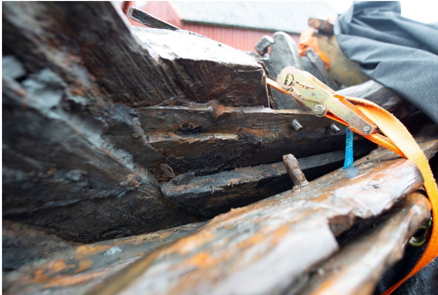
Figur 21: Detalj fra babord baugparti. Vi ser hvordan bordgangene er festet i stevnen med nagler. Under strammeren ser vi også to trenagler i landet mellom to bordganger. Foto: Fredrik Skoglund, NTNU Vitenskapsmuseet
