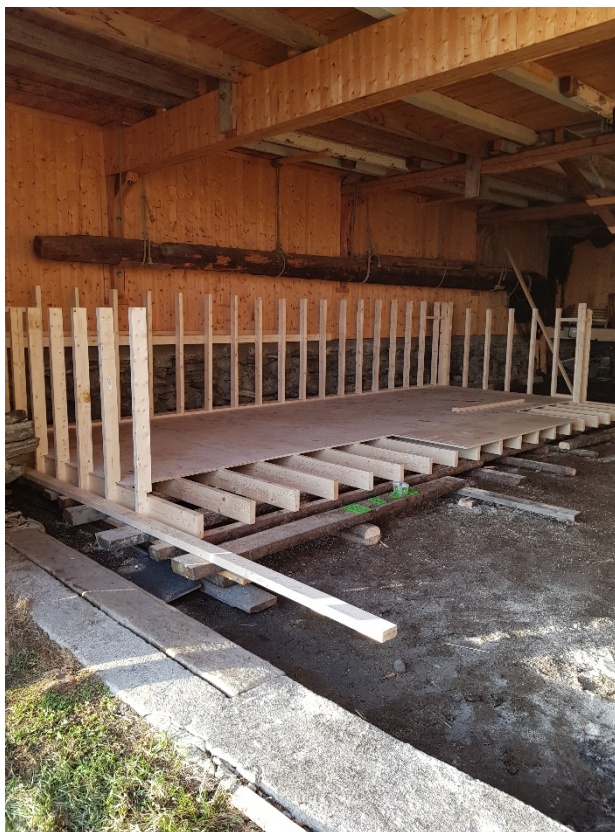
Figur 55: Karet, hvor vraket skal ligge i ferskvann, og mulig PEG-behandling for konservering, er spesialbygd og satt opp i et av museets naust. Foto: Hilde Murvold Borgfjord
