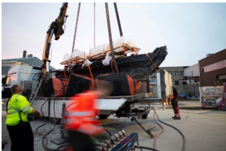
Figur 50: På lastebilen plasseres vraket trygt på store oppblåsbare puter som stabiliserer det. Foto: Thora G. Nyborg, NTNU Vitenskapsmuseet
