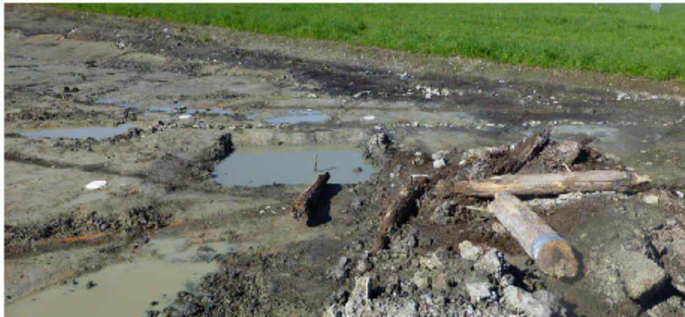
Brønnområdet før utgraving
