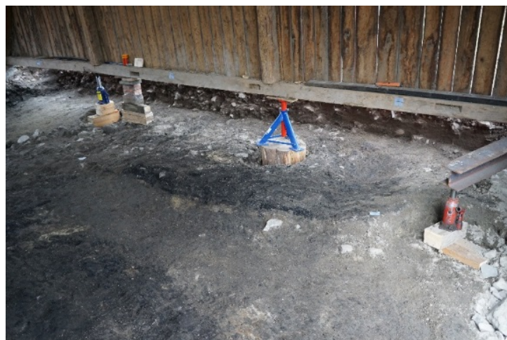
Figur 7. NØ-veggen måtte støttes opp på vekslende punkter etter hvert som vi gravde oss nedover. Da62669_006. Foto: Silje E. Fretheim, NTNU Vitenskapsmuseet
